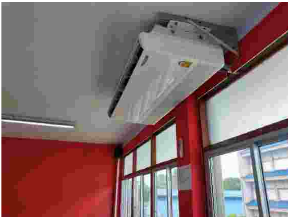
การติดตั้งเครื่องปรับอากาศศูนย์ HCEC
