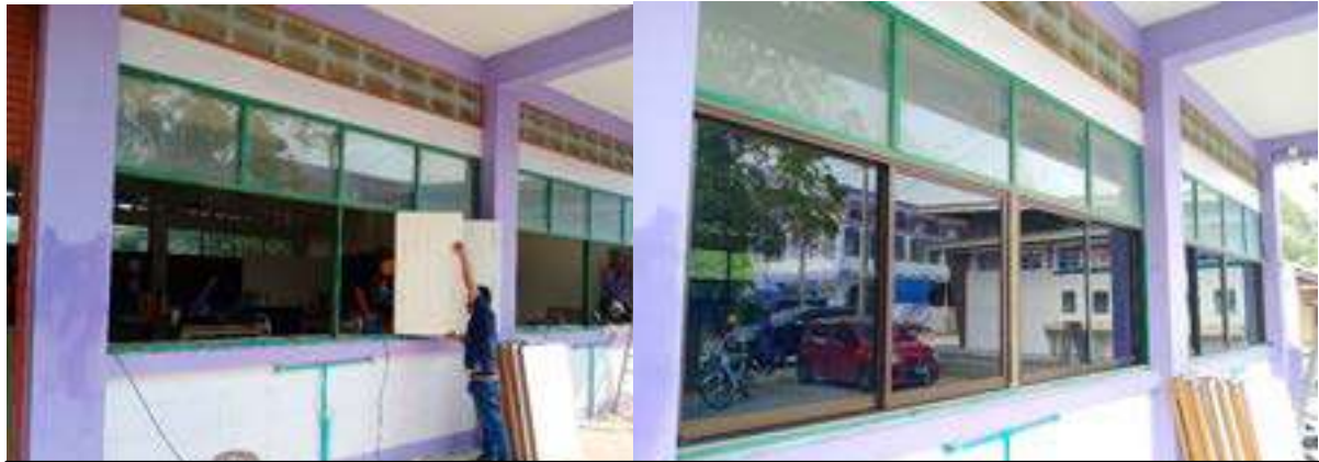
เปลี่ยนและติดตั้งหน้าต่างระจกรอบห้องคหกรรม
